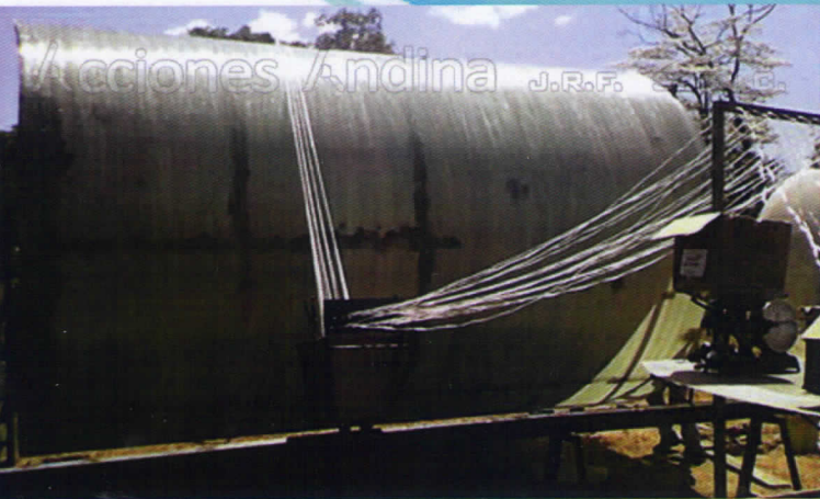
(Detalles constructivos en sitio, de tanques en PRFV "Rolados por Hilos Continuos, Tecnología Woven Roving".)
