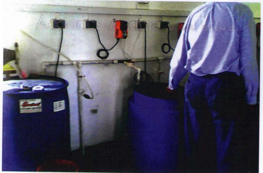
Instalación de Bombas Dosificadoras de Productos Químicos – Tablero Arrancador “tipo” (Ptap de Sortová, Provincia de Chiriquí, Panamá.. 12 LPS)
