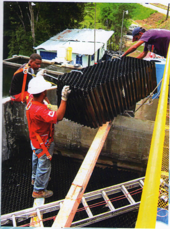
(Ptap de Santa Marta, Provincia de Chiriquí, Panamá 30 LPS.. Detalle: Colocación de Módulos de Sedimentación en tanque sedimentador, planta superior de Tanque clarificador)
