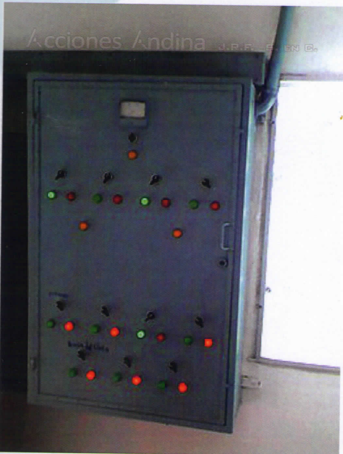
Instalación de Bombas Dosificadoras de Productos Químicos – Tablero Arrancador “tipo” (Ptap de Sortová, Provincia de Chiriquí, Panamá.. 12 LPS)
