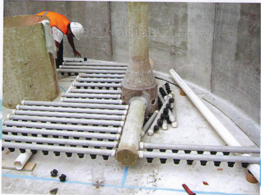
(Ptap de Santa Marta, Provincia de Chiriquí, Panamá 30 LPS.. Detalle: Colocación de Módulos de Sedimentación en tanque sedimentador, planta superior de Tanque clarificador)
