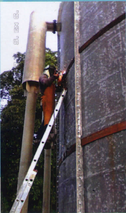
(Detalles constructivos en sitio, de tanques en PRFV: instalación y Soldadura de Correas Metálicas Perimetrales.)
