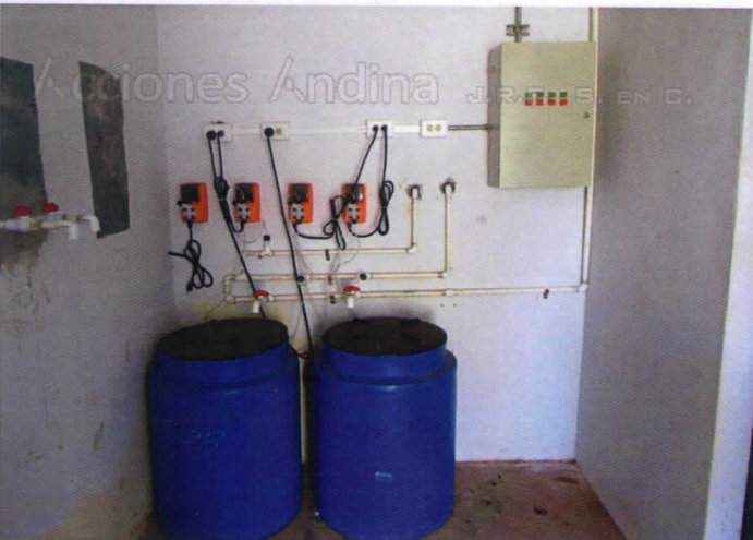
(Sistema de dosificación de Productos Químicos "tipo", con Bombas dosificadoras eléctricas programables, tanques de solución de productos químicos formulados y tubería de distribución)
