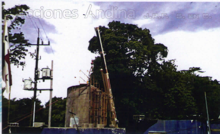
(Transporte a sitio de instalación de elementos y tanques) (Armado de casquetes y partes de tanques en sitio definitivo)
