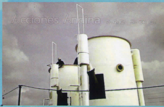
(Ptap de Escobal, (Zona de Colón), Panamá 18 LPS Detalle: Instalación de Sistema de Dosificación de Productos Químicos a tanques clarificadores) Proyecto IDAAN, Blackwater Panama S.A.
