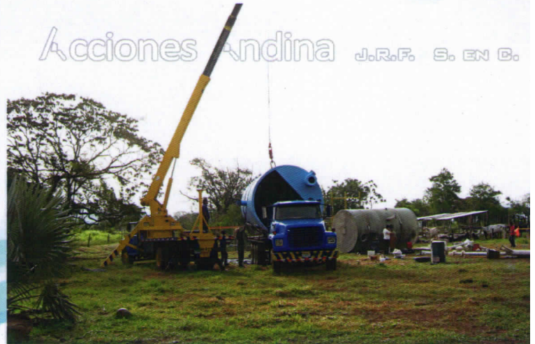
(Transporte a sitio de Instalación de tanques en PRFV)
