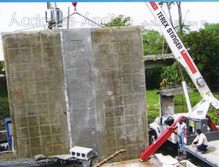
(Armado de casquetes y partes de tanques en sitio definitivo, con apoyo de equipo de izaje especializado)
