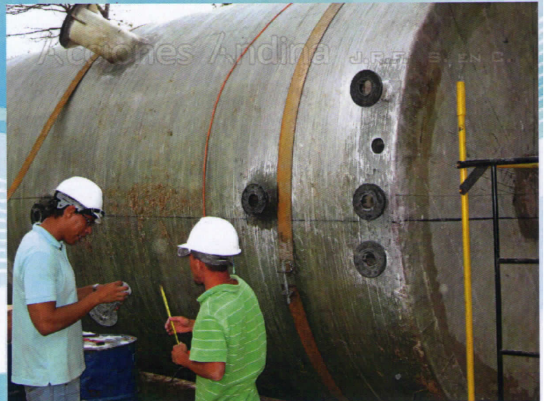
(Detalles constructivos en sitio de tanques en PRFV. Control de calidad de elementos componentes de tanques clarificadores)
