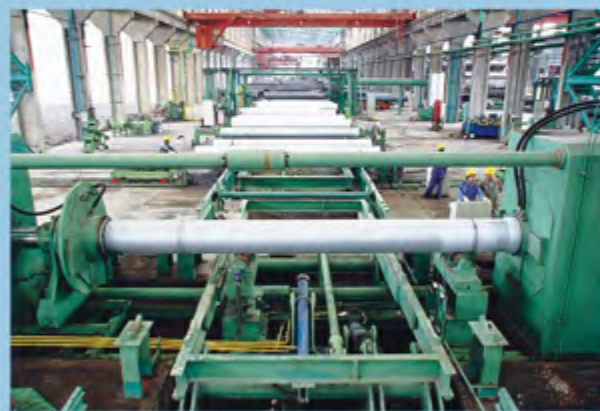
水压试验 Hydraulic pressure testing
