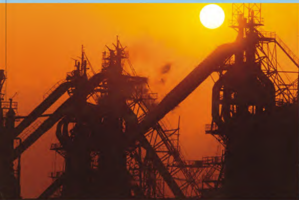
高炉炼铁 Blast furnace
