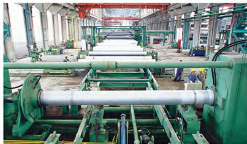
水压试验 Hydraulic pressure test
