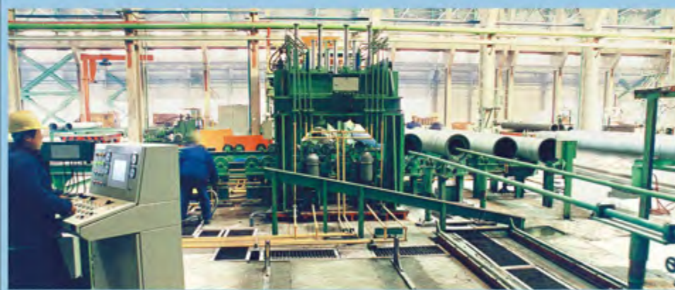
水泥衬层 Cement lining
